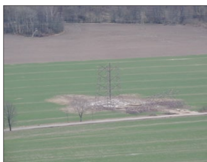
Wieża po stronie południowej w fazie montażu
