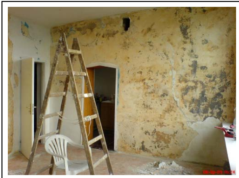
lokal w trakcie remontu - renowacja
