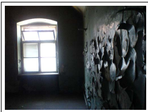
kamienica na Kazimierzu... fatalny stan ścian...
